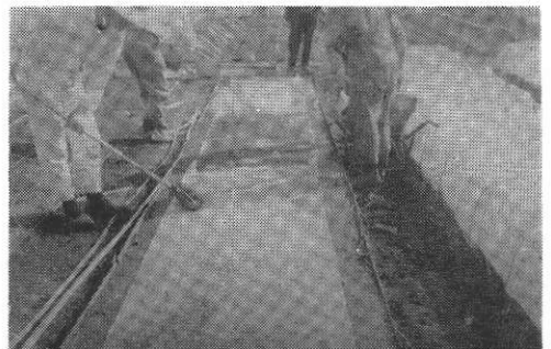
写真1 床土にネットを敷きローラーで鎮圧
