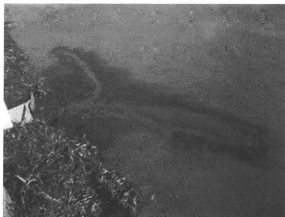
写真 1 水流による水尻周辺土壌の侵食
