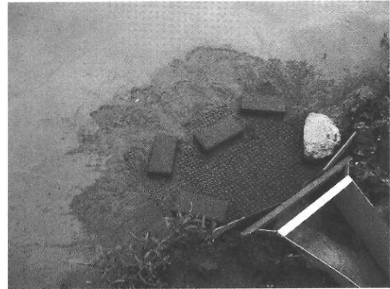
写真 2 排水口周りを人工芝で保護し侵食を防止する
