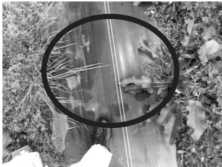
図 1 導電性防草シートの外側からの下草の侵入
