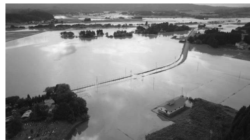
図3 雄物川越流の状況 (7月23日16時頃泉沢ため池付近上空から大正寺地区方向をドローンにより撮影)
