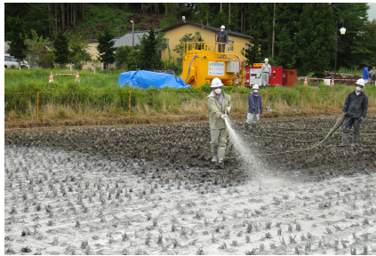
図 1 土壌固化剤の散布状況
