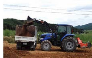
c 排出:フロントローダとダンプトラック
