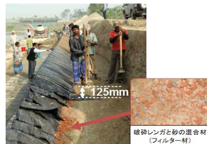
(c) 盛土材料の締め
