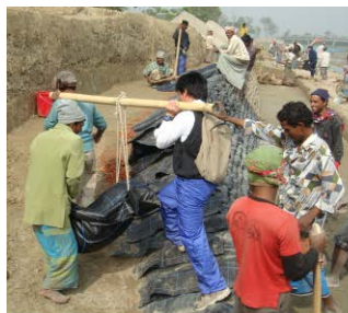
(a) 土嚢の運搬作業
