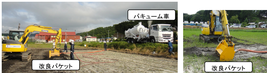
図 3 油圧ショベルの改良バケット（ワイパー・バキューム工法）
