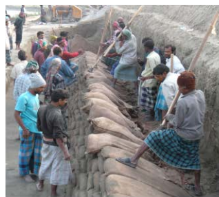
(b) 土嚢の締め作業
