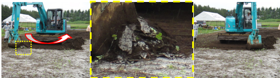
図 2 表層土の剥ぎ取り状況（ワイパー工法）
