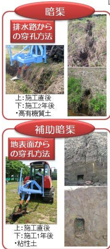
図2 施工の概要
