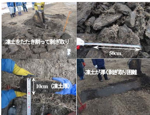
写真1 無対策の剥ぎ取り状況
