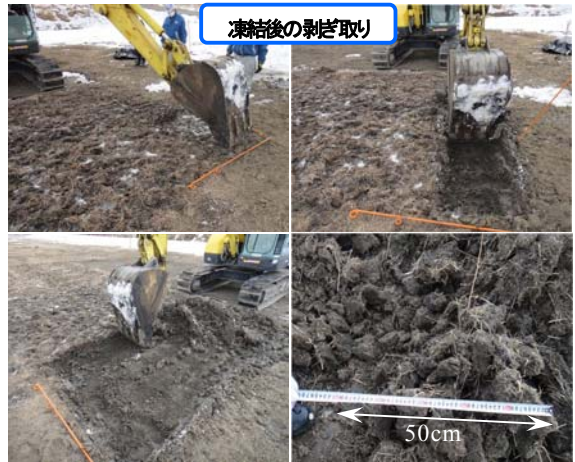
図1 冬期の剥ぎ取り工法(新工法)の概要
