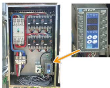
図2 製品化された気温差制御を行う防霜ファンの制御盤
