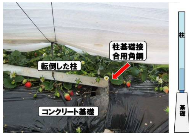
図2 柱基礎の接合部材の折れ曲がり：接合用角型鋼管（45×45 mm）が折れ曲がり柱（50×50 mm）はほぼ水平になるまで転倒していた
