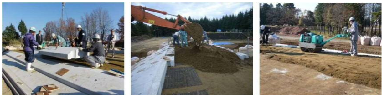
(a) ジオテキブロックの据付 (b) セメント改良土の撒出し (c) セメント改良土の転圧
