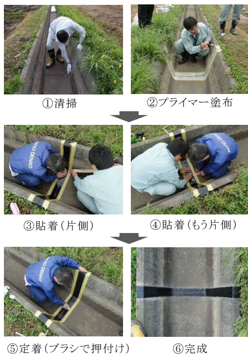
図2 漏水補修テープの施工手順
