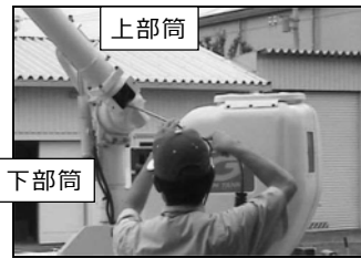
【排出オーガ上部の清掃風景】
