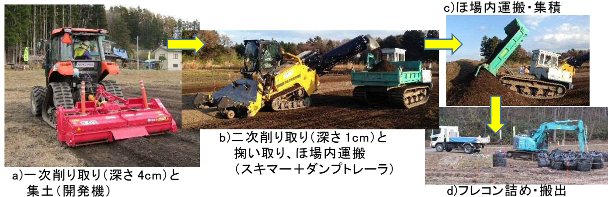
図2 飯舘村除染事業区での作業例(表土削り取り機とスキマーとの連携作業)
