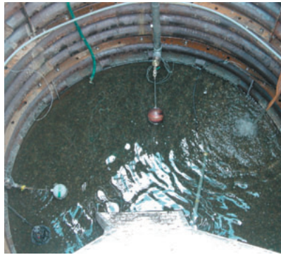
図1 浸透試験状況
