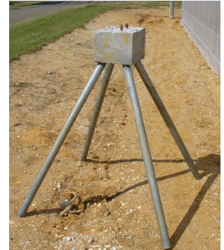
図1 パイプ斜杭打込基礎
