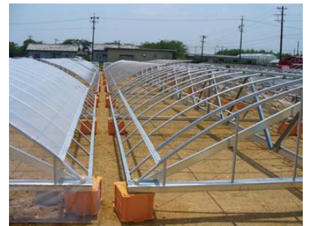
図1 パイプ斜杭打込基礎
