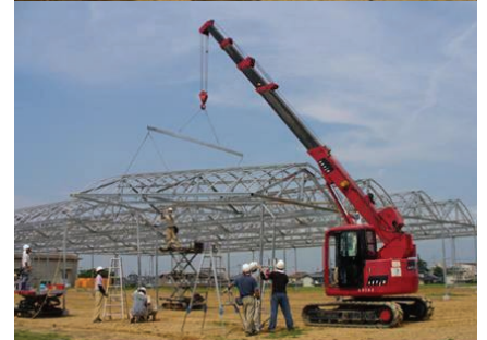
図2 屋根部の地上組み立てとクレーンつり上げ
