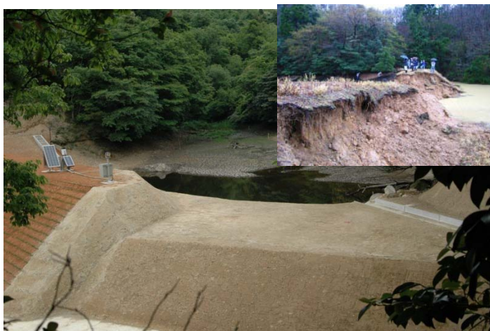
●能登半島沖地震によって決壊したため池の「越流許容型ため池工法」による復旧事例
