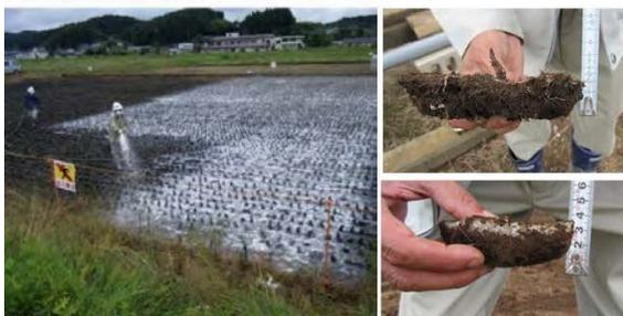
固化剤の吹きつけ作業と固化後の状況（左図）はぎ取る表土を固化すると、流出や飛散が防止され、固化部分の物性の違いにより、選択的なはぎ取りが可能となります。さらに、固化剤により、表層の土壌が白く着色されるため、削り取り状況を目視により確認しながら作業を行うことが可能です。
