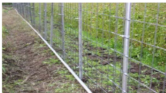
柵の接地部を直管パイプで補強することでイノシシのくぐり抜けを防止できる
