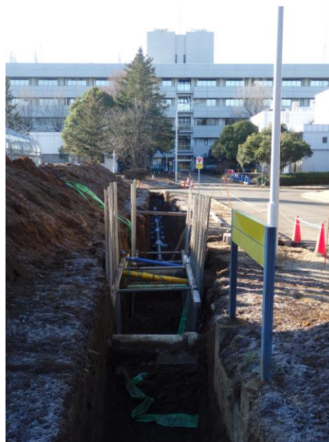
写真：（左）研究本館エレベーター改修工事、（右）A,C 地区上水設備改修工事
