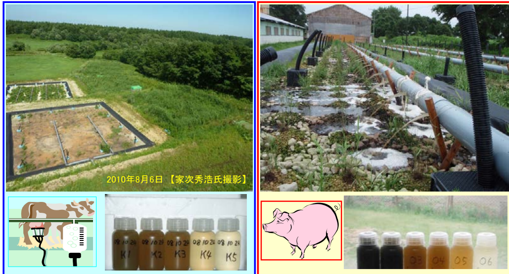
写真1 ハイブリッド伏流式人工湿地システムの現地施設と処理水(例)
