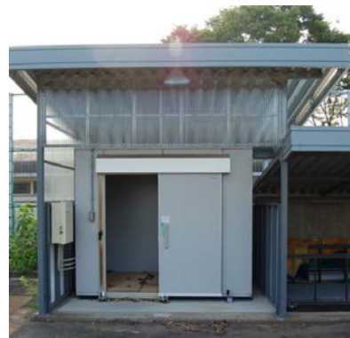
図6 貯桑室（クワを保管する冷蔵室）
