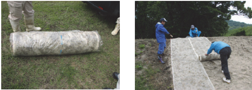
図1 「シバ二重ネット工法」に用いるロールと畦畔法面における二重ネットの展開
