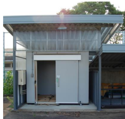
図6 貯桑室(クワを保管する冷蔵室)
