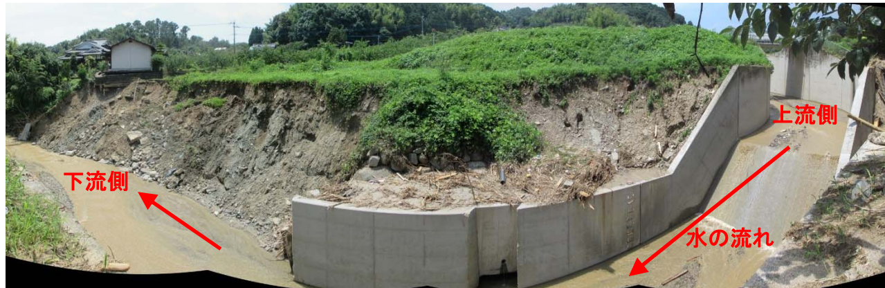
梅ヶ谷1ため池の堤体及び洪水吐(下流から)
