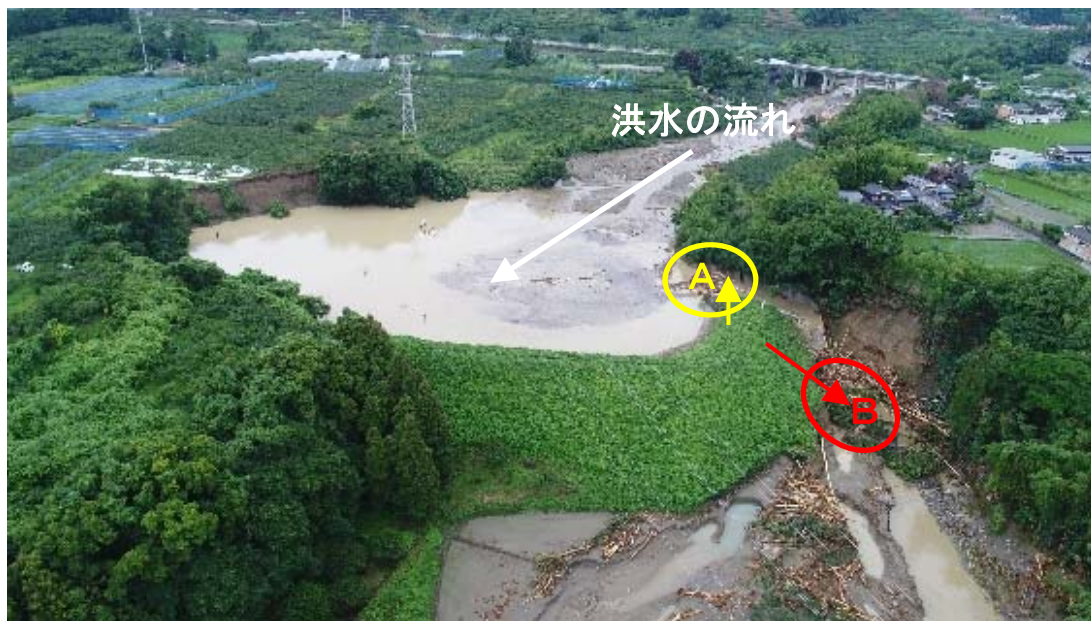
土砂を受け止めた鎌塚ため池(下流から上流を望む)
