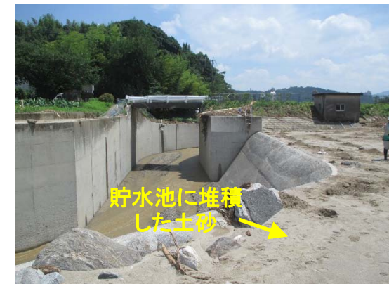
洪水吐越流部(Aの拡大写真)
