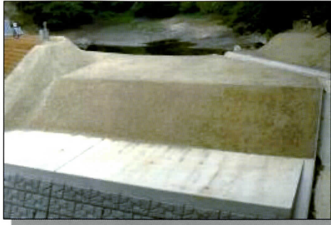
図5 完成した越流部
