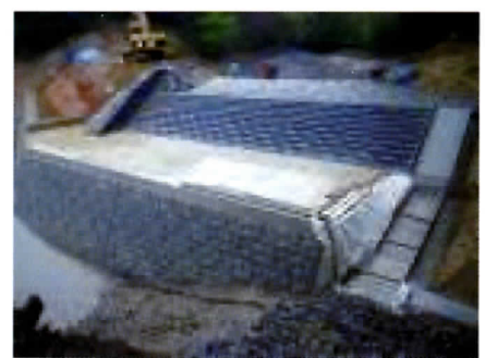
c. 土嚢の設置完了
