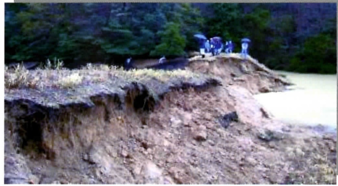
図2 能登地震によって決壊した平田池
