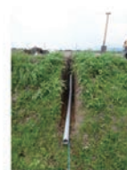
水こう（排水口）部分は塩ビ管を設置します。
