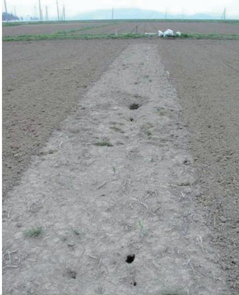
疎水材の劣化等による暗渠機能(施設自体)の低下
