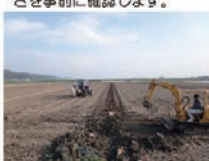
⑤水閘部、通気孔部を埋め戻します。
