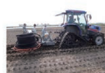
この手法では暗渠管は水平に布設されます。
