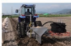
④暗渠管の敷設と疎水材の投入を行います。
