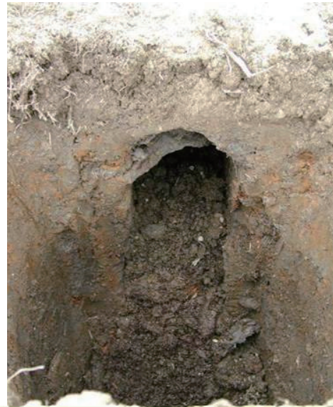
疎水材の劣化等による暗渠機能(施設自体)の低下
