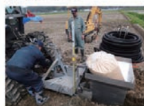
③暗渠管敷設後の修正ができないので、浅層暗渠施工器による開削のみを行い、暗渠管が埋設される深さを事前に確認します。
