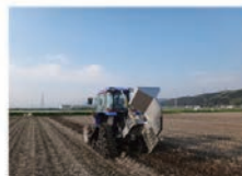
⑥掘削した位置をトラクタで踏圧します。
