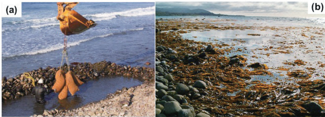
図3 鉄分供給ユニットの施工事例（工事風景と9年目の様子）
