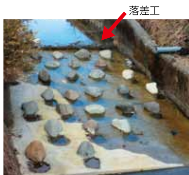
■生息場・生態系ネットワークの保全技術 落差工に粗石付き斜路式魚道を設置したことにより、魚類が遡上できるようになった。 (施工：関東農政局、設計協力：農村工学研究所)
