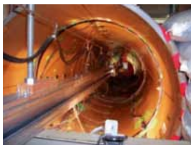
■交通荷重を考慮したパイプラインの 載荷試験
