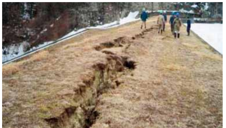
■2011年東日本大震災で被災したため池堤体の危険度診断
