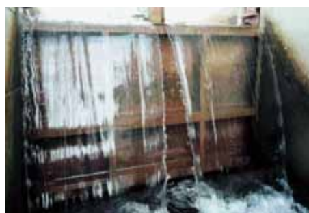
■落下水脈の低周波騒音低減装置 左：水膜振動により低周波騒音を発生させる落下水脈 右：低周波騒音低減装置設置後の落下水脈
