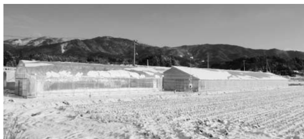
写真1 実証試験地における試験研究用ハウスの外観 注) 左側が高保温・高強度パイプハウス, 右側が建設足場資材利用園芸ハウス
