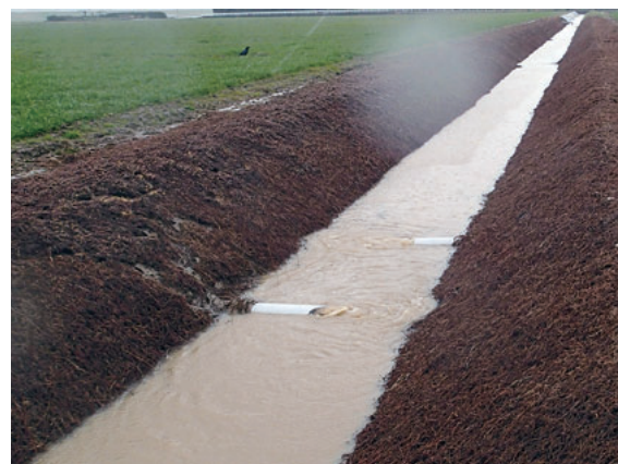
図43 排水路の水位が高い状態
