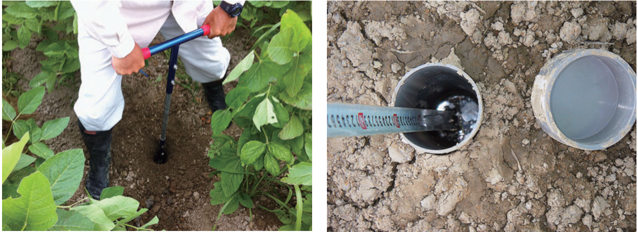
図49 縦穴の施工（左）と地下水位の測定（右）
