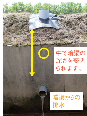
図36 横からみた水位制御器
