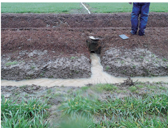
図42 明渠を掘って排水を促す
