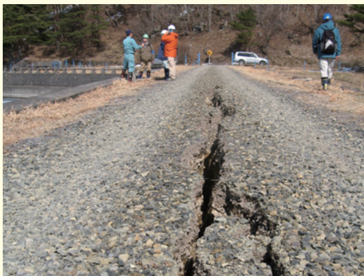
東日本大震災で被災した、ため池の危険度診断
