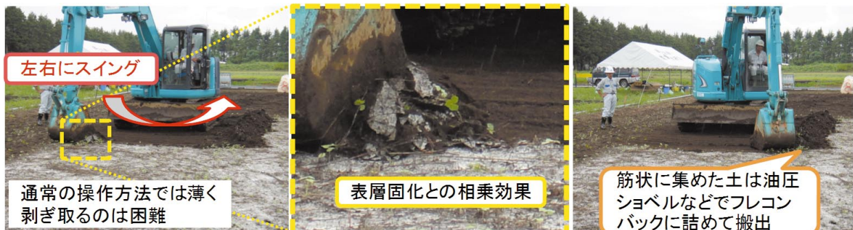
図2 表層土の剥ぎ取り状況(ワイパー工法)
