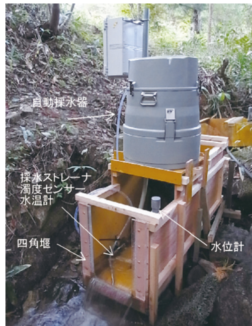
(c) 斜樋流出口の採水地点と観測機器
