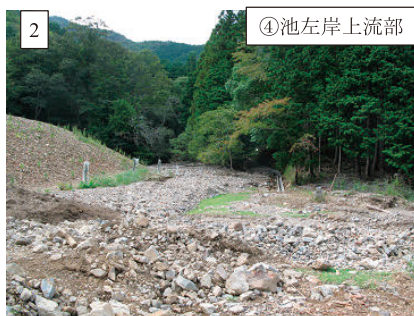
Fig. 17 ④池左岸上流部から流入した土砂 Sand and mud flowed from left side bank upstream of ④ ike
