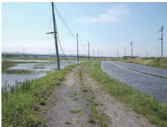
写真1 田面(左側)と排水路(右側)の位置関係 (図1のLINE4下流(北側)付近)
