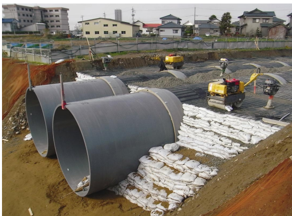
写真 大口径パイプの浅埋設施工状況（九頭竜川農業水利事業地区）
