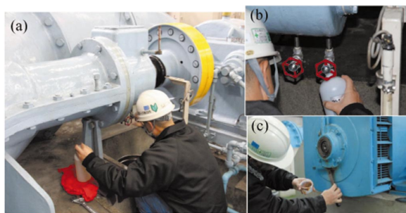
(a) 採取状況 (b) 潤滑油 (c) グリース 図1 潤滑油やグリースの採取状況
