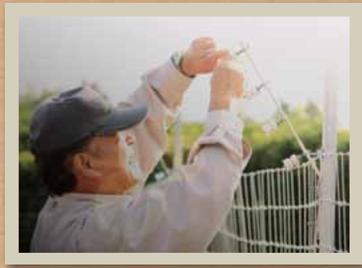
(写真： 碍子に柵線をひとつひとつ手で張る様子)
