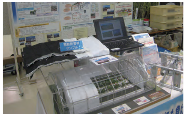
ダブルアーチ構造にして強度を高めた次世代ハウスの模型
