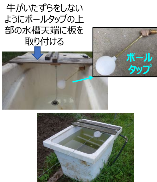
図 2123-2 水槽へのボールタップの取り付け
