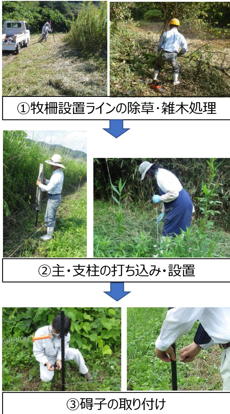
図 2112-1 電気牧柵設置の作業手順（その1）
