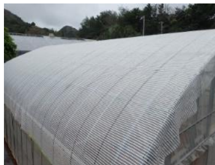
写真3 遮光ネットの設置の様子
