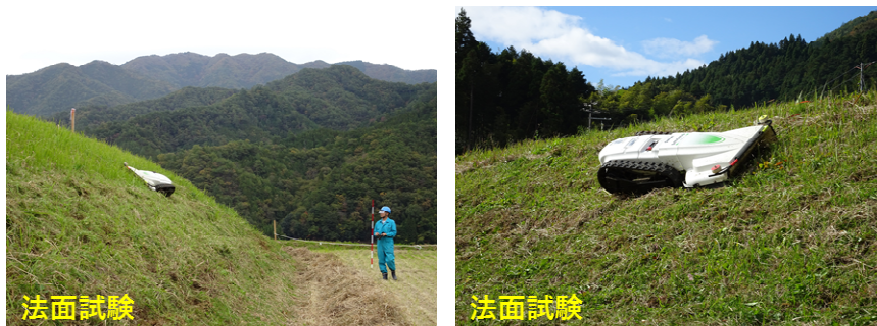
図2 電動リモコン草刈機「スマモ」による現地試験の様子(兵庫県養父市)
