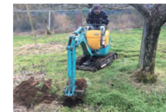
図5) バックホーによる土壤改良処理
