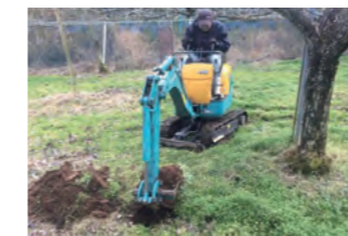
図5) バックホーによる土壤改良処理
