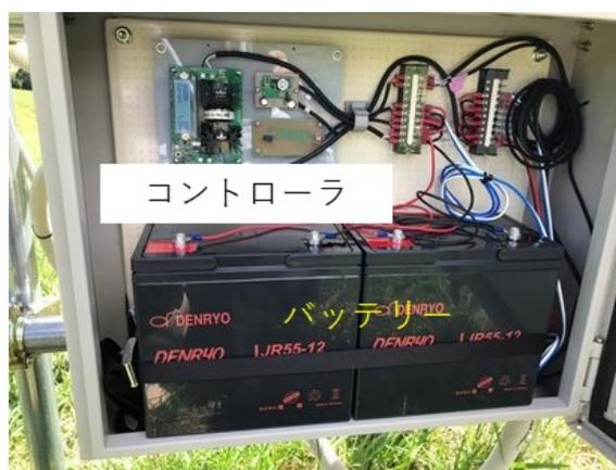
図14 バッテリー部の構成
