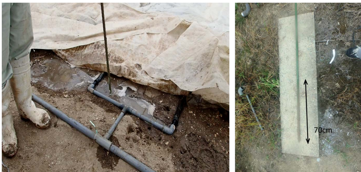
図 8-3 農業用支柱による土壤深層部の湛水状況の確認
