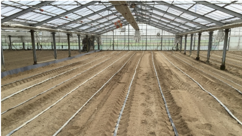
図 3-5 灌水チューブの設置
