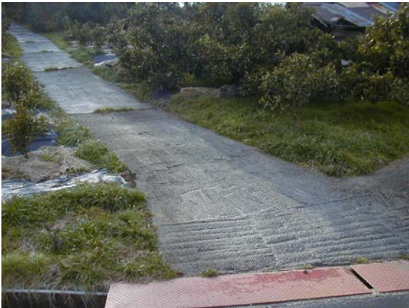
作目： ミカン、果樹 作業： 圃場・施設整備 目的： 圃場整備、効率化・省力化 方法： 園内道を設置。
