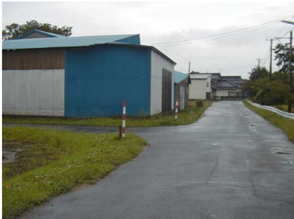
作目： 共通 作業： 圃場・施設管理 目的： 作業安全 方法： 通路の角へポールを設置。
