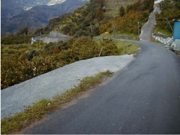
作目： ミカン、果樹 作業： 圃場・施設整備 目的： 圃場整備、効率化・省力化 方法： 園地への取付け道を設置。
