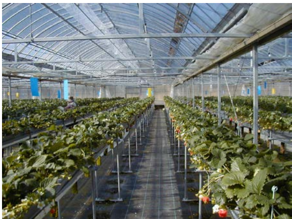
作目： イチゴ、野菜 作業： 圃場・施設管理 目的： 作業姿勢改善 方法： 高設栽培ベッド（高さ1m、幅0.3m）を設置。通路幅0.9m。
