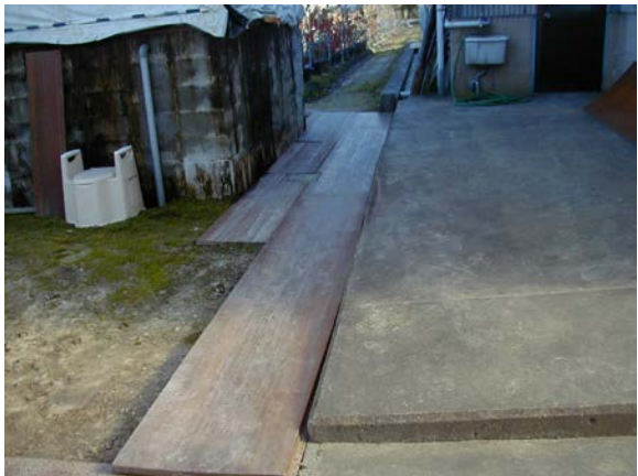
作目： 共通 作業： 圃場・施設管理 目的： 圃場整備 方法： 側溝の上に、板を敷いた。
