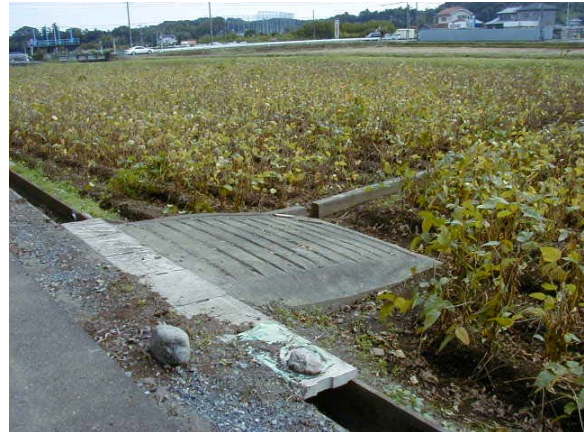
作目： 共通 作業： 圃場・施設管理 目的： 圃場整備、作業安全 方法： 圃場出入り口をコンクリートで造成。 滑りにくいように、路面に凹凸を付けている。
