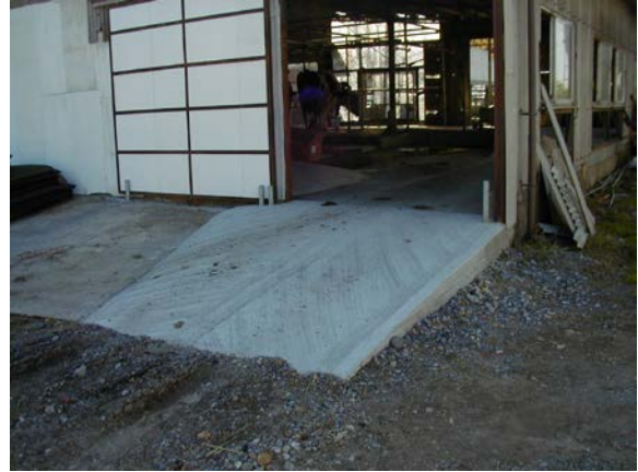
作目： 酪農、畜産 作業： 圃場・施設管理 目的： 施設整備 方法： 畜舎の段差へスロープを設置。
