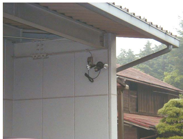
作目： 共通 作業： 圃場・施設管理 目的： 施設整備、作業安全 方法： センサ付きライトを設置。
