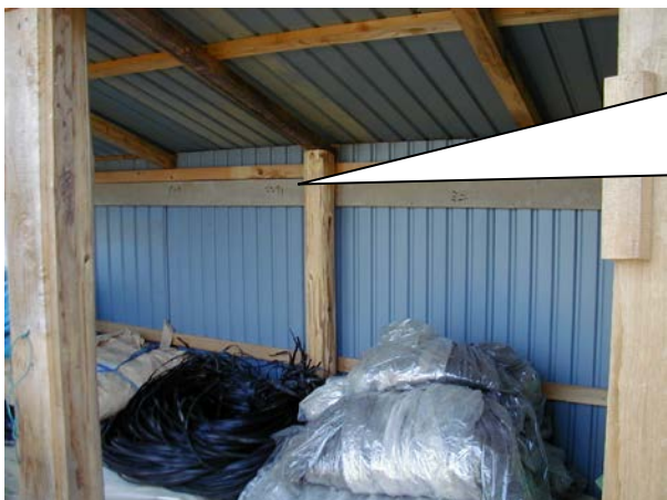
保管庫内にも用途を記入
