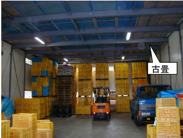
ミカン貯蔵庫の天井に断熱材（古畳）を設置
