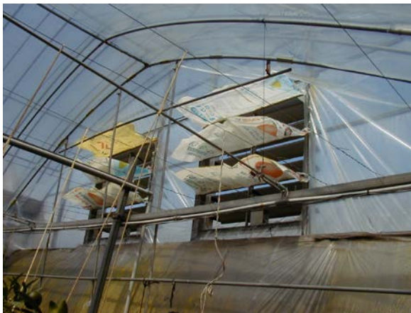
換気ファンにビニールで開閉するフタを追加
