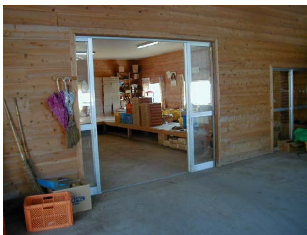
低い敷居の出入口
