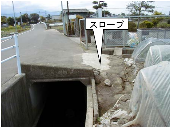
スロープ設置圃場
