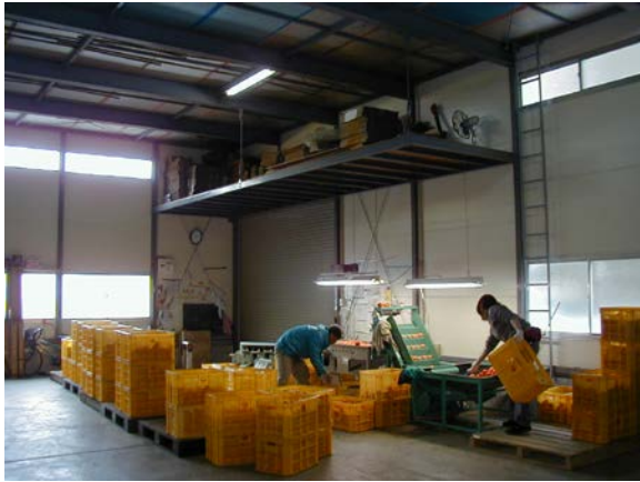
作目：共通 作業：圃場・施設管理 目的：施設整備 方法：倉庫の上部の空きスペースに棚を設置。
