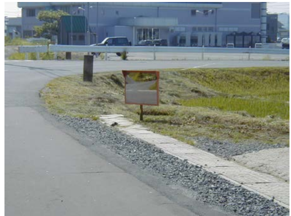
作目：共通 作業：圃場・施設管理 目的：作業安全 方法：交差点にカーブミラーを設置した。
