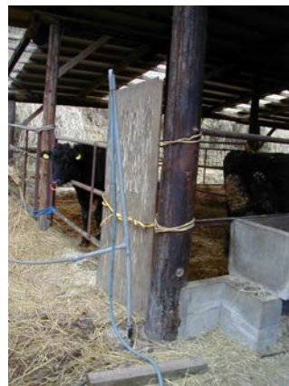
作目：畜産 作業：家畜管理、圃場・施設管理 目的：施設整備 方法：サイホンの原理で畜舎内へ給水。
