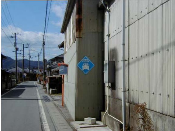
作目：共通 作業：共通 目的：作業安全 方法：道路に面した格納庫出入口へ、「農耕車 出入口注意」注意警告板設置
