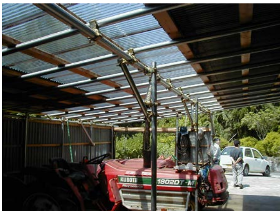
作目：共通 作業：圃場・施設管理 目的：明るさ調節 方法：倉庫内へ太陽光がさしこむよう壁の一部へ半透明の板を取付け。
