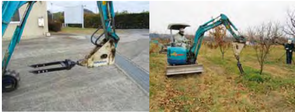
写真 6-1-2 ブレーカ用アタッチメントとそれを用いた処理
