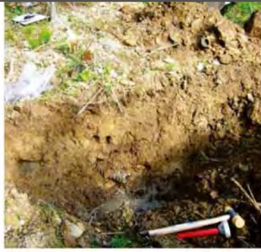
試掘により 地下水位の高いことが判明
