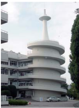
東海大学 熊本キャンパス2号館
