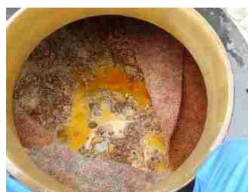
図3 脱臭材料表面の目詰まり (3号機)
