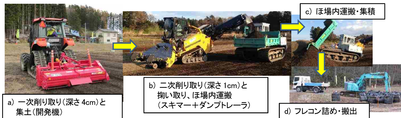
図2 飯館村除染事業区での作業例（表土削り取り機とスキマーとの連携作業）
