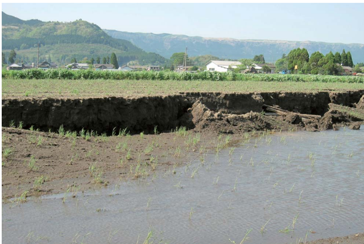
熊本地震による被害
