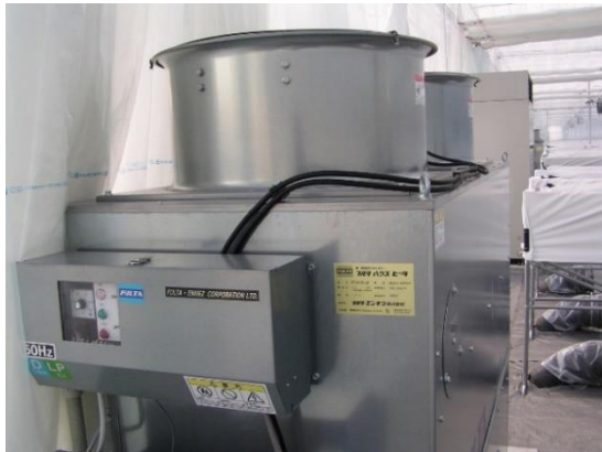
LP ガス温風機（左）と温風ダクト（右）
