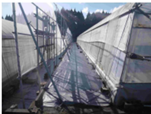
図2-28 抑草シートの設置
