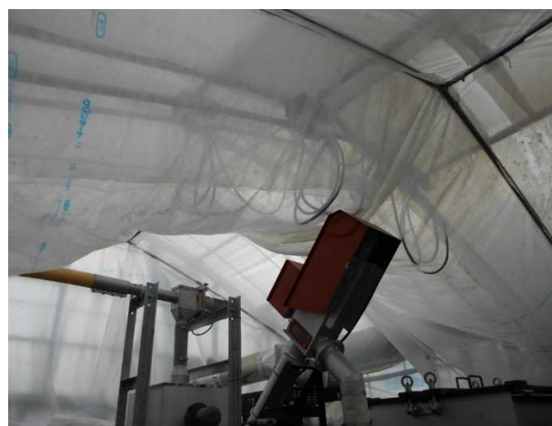
図2-40 加温機上部の1層、2層の隙間をビニルで閉塞
