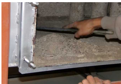
図2-36 燃焼灰の除去作業の様子
