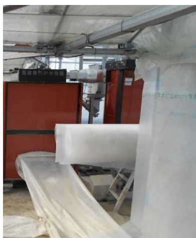
図2-39 ハウス内側に保温資材（エコポカプチ）を設置
