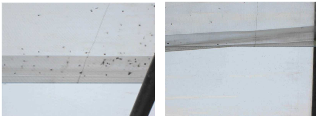
図 2-27 適正な設置で虫を防止したネット (左) と隙間のあるネット (右)
