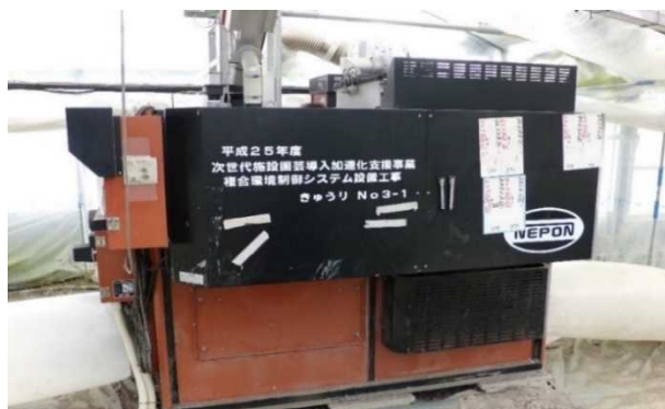
図2-35 木質ペレット暖房機（N社製）
